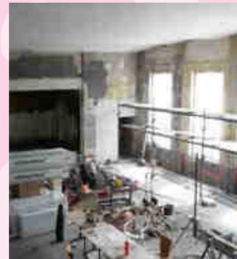
wurden nicht nur die Dachhaut des flachen Nebengebäudes erneuert, sondern auch das Saal-Dach montiert. Es entstand eine neue Frontansicht des Saalgiebels mit weiteren Fenstern und die gesamten Räumlichkeiten wurden neu aufgeteilt. Mit Beginn des neuen Jahres ging der Innenausbau weiter: Eine schallgerechte Innendecke wurde montiert, die Nebenräume mit Elektrik, Putz, Heizkörpern und Estrich ausgestattet, im Saal wurde die aufwändigere Elektroverkabelung für die
